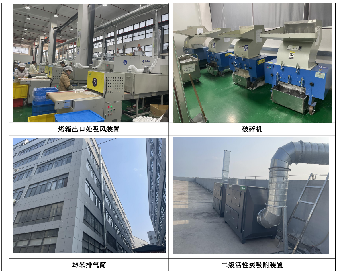
图3-2 项目废气处理设施
